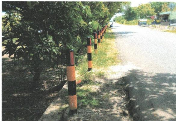
Gambar 39. *Delineator* Pipa Besi
