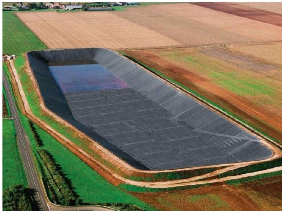
Gambar 6.1 Penanganan Makro dengan Pembuatan embung dengan dilapisi geomembran agar dapat menampung air
