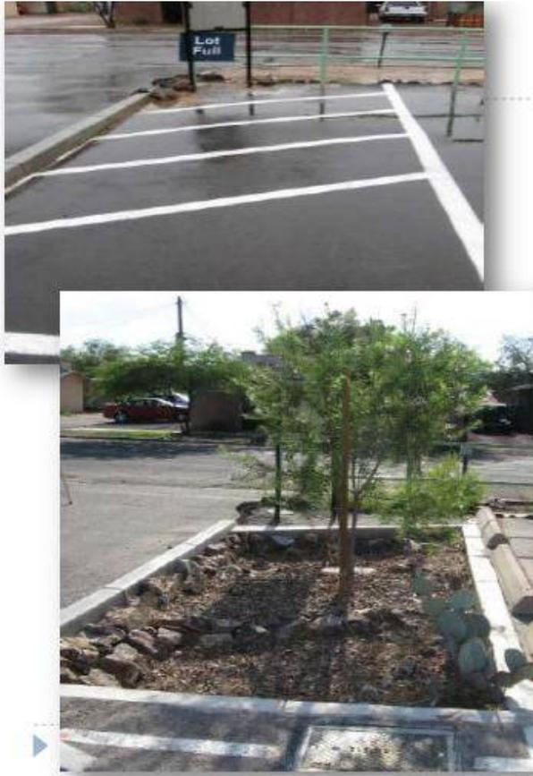
Ruang yang tidak digunakan pada tepi lahan parkir diubah menjadi kolam retensi dengan cara membuang aspal dan menggantinya dengan bio-retensi. Pembatas jalan dibuat bercelah sehingga air dari lahan parkir mengalir ke bio-retensi. Bio-retensi juga dapat menampung air dari jalan.
